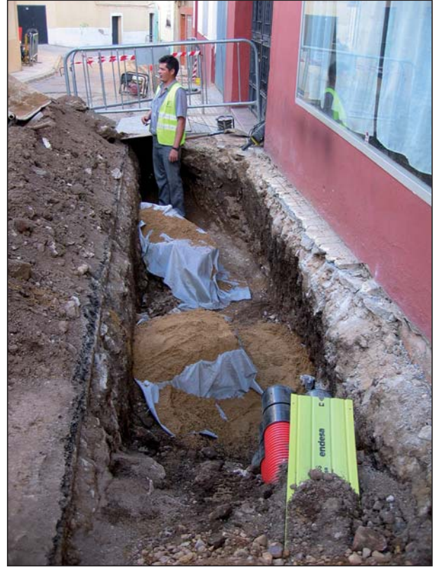
FIGURA 7 Cubrición de los restos.
